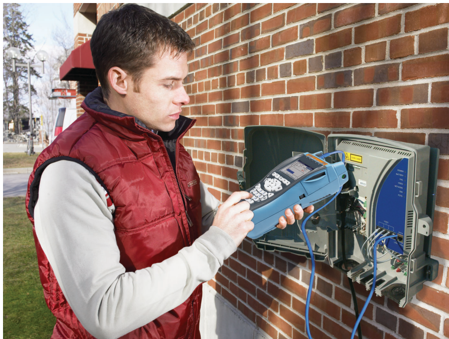
Tests IPTV sur un port Ethernet d'un terminal de réseau optique.
