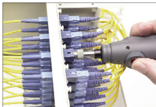
Inspección de separación de paneles de conexiones
