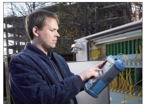
Vollständige Mittelwertbildung in nur 45 Sekunden mit den OTDR-Kurzstreckenkonfigurationen
